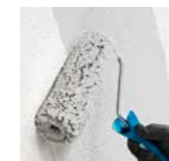
7 Auftragen des Farbansichts
