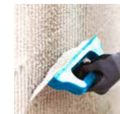
5 Einbetten des Armierungsgewebes mit Armierungsmörtel
