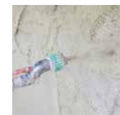
3 Aufbringen des Dämmputzes
