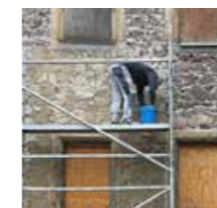
2 Evtl. vorbereitende Maßnahmen wie Vorspritz oder Aufbringen eines Putzträgers wie Schilfmatte oder Welnet.
