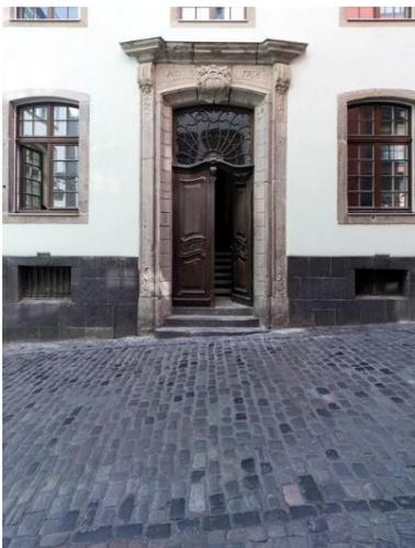
Über dem Basaltsockel wurde der Putz handwerklich angepasst und ca. 2 bis 3 cm überstehend aufgetragen, sodass Regen künftig vor dem Sockel abtropfen kann.
