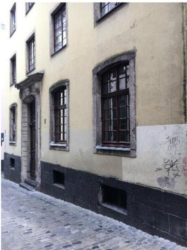
Vor der Sanierung: Die alte Fassade war mit den unterschiedlichen Putzmaterialien, Rissen, Abplatzungen und Moosbewuchs auf den Natursteingewänden ein echter Sanierungsnotfall.
