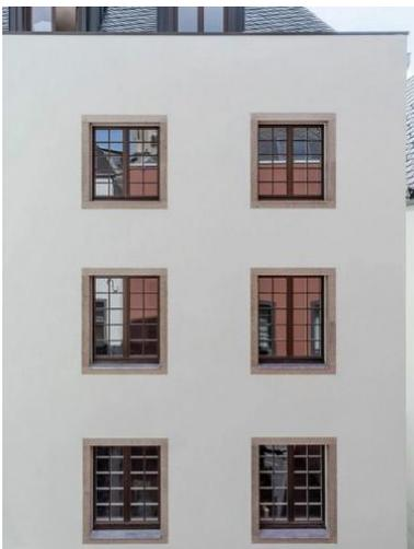
Die Fassade wurde mit dem Hasit Hochleistungsdämmputz auf Aerogel-Basis energetisch saniert.
