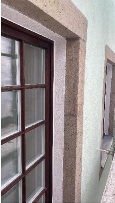
Der Spalt zwischen den historischen Fensterfassungen und den neu positionierten Natursteingewänden wurde mit Dämmputz aufgefüllt, um Wärmebrücken zu vermeiden.
