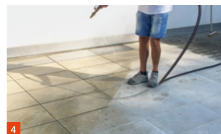
4 Bagnare la superficie con acqua
