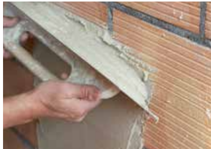
Directement sur la brique ou la brique silico-calcaire Fixit 125 / Fixit 632 Rapid
