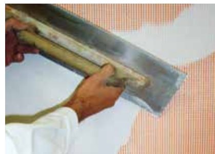
Enrobage de treillis d'armature Fixit 460 / Fixit 461 / Fixit 462
