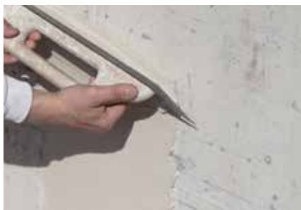
Directement sur le béton Fixit 125 / Fixit 632 Rapid
