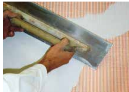
Enrobage de treillis d'armature Fixit 460 / Fixit 461 / Fixit 462
