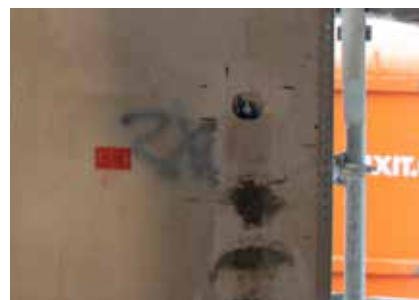
Anciens enduits à la résine synthétique Fixit 460 / Fixit 461 / Fixit 462
