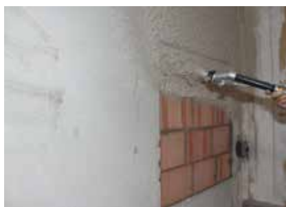
Égalisation du support Fixit 125* / Fixit 632 Rapid
