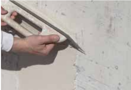
Directement sur le béton Fixit 125 / Fixit 632 Rapid
