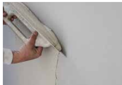
Directement sur le plâtre cartonné Fixit 125
