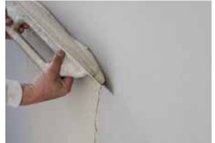
Directement sur le plâtre cartonné Fixit 125
