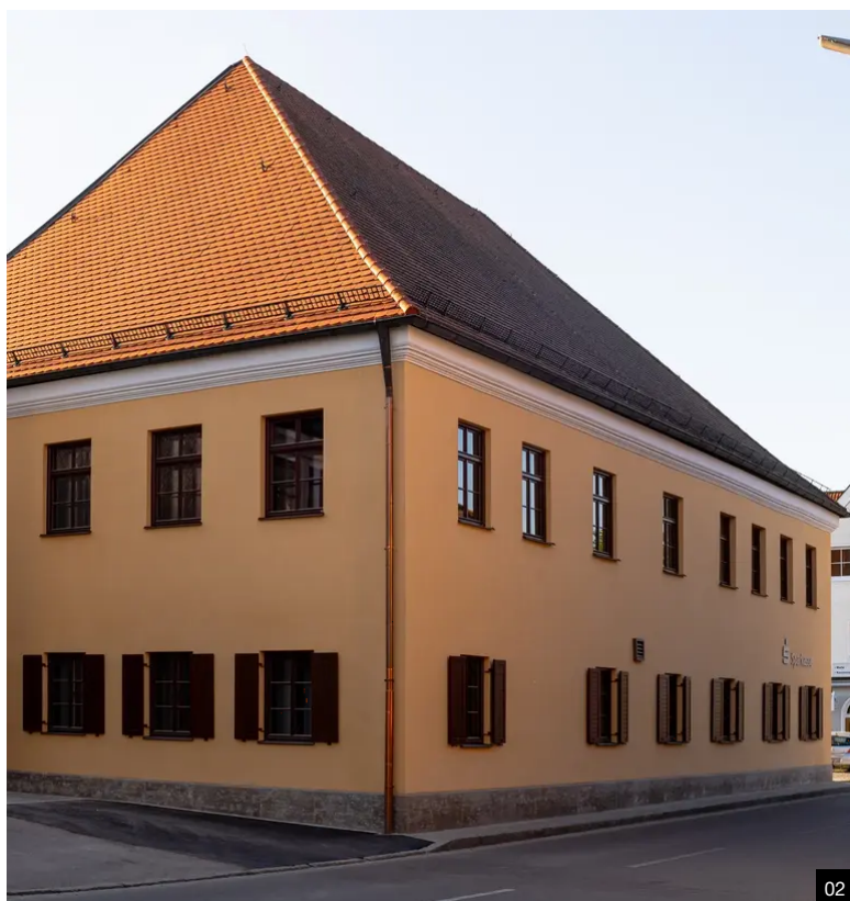
01/02: Sanierte, schöne Außenfassade – gedämmt mit unserem Dämmputz. 03/04/05: Außenansicht nach Entfernung des Altputzes - nach dem Ausgleich des Untergrundes wurde das Dämmputzsystem aufgetragen.
