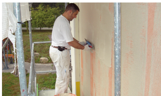
Enduit de fond avec enrobage du treillis
