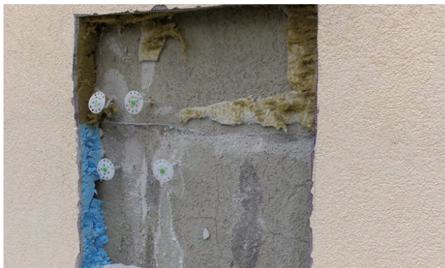
Sondage de grandes surfaces
