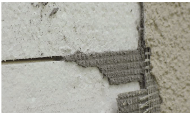
Mortier dans le joint du panneau
