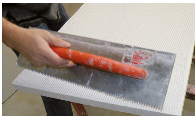
Application de la colle avec la truelle dentée
