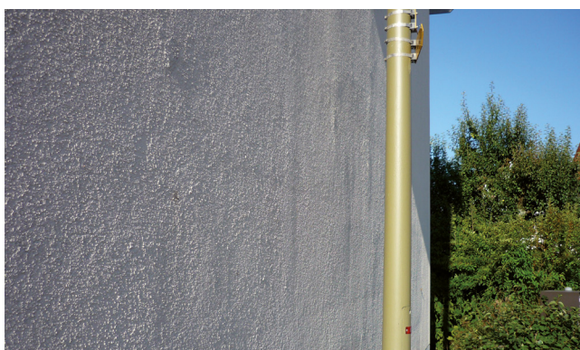
Marquage des joints des plaques
