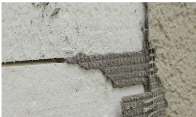
Mortier dans le joint du panneau
