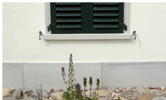
Soubassement fibro-béton (GFB)
