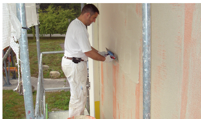
Enduit de fond avec enrobage du treillis
