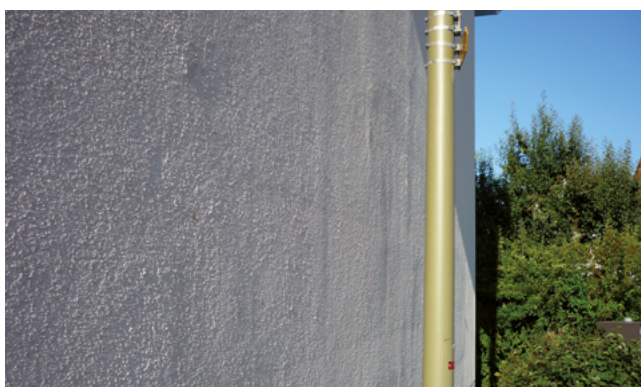
Marquage des joints des plaques
