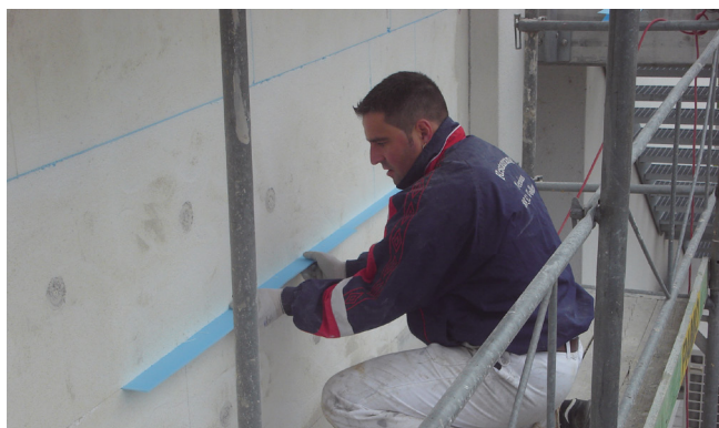
Fermer les joints de panneau ouverts avec cales XPS
