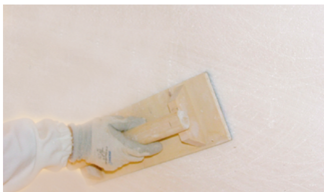
Poncer la surface de la façade EPS
