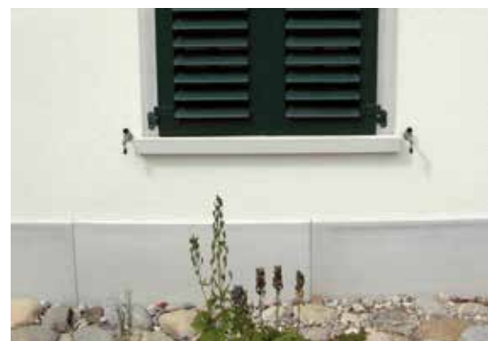
Soubassement fibro-béton (GFB)
