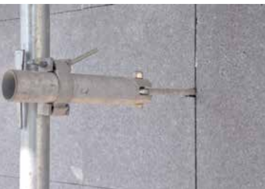
Ancrage de l'échafaudage
