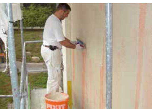
Enduit de fond avec enrobage du treillis
