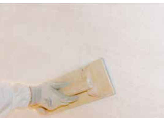
Poncer la surface de la façade EPS
