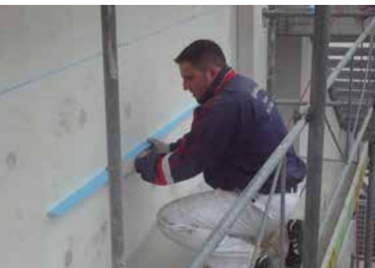
Fermer les joints de panneau ouverts avec cales XPS
