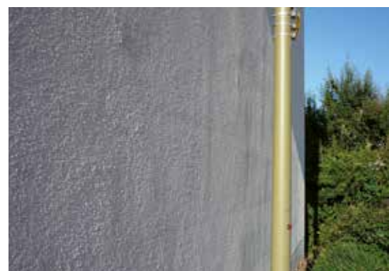
Marquage des joints des plaques
