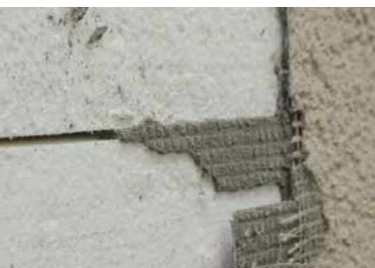
Mortier dans le joint du panneau
