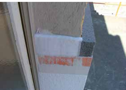
Embrasure avec Aerogel et structure crépie
