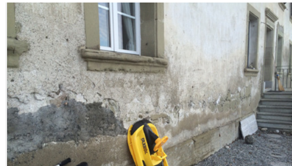
aufsteigende Feuchtigkeit
