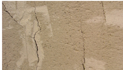
kleine Schwindrisse im frischen Zustand
