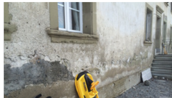
aufsteigende Feuchtigkeit
