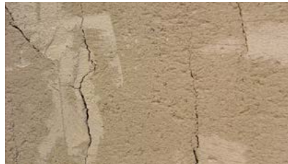
kleine Schwindrisse im frischen Zustand
