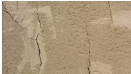
kleine Schwindrisse im frischen Zustand
