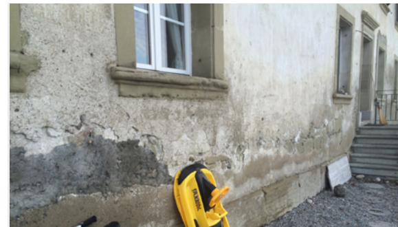
aufsteigende Feuchtigkeit
