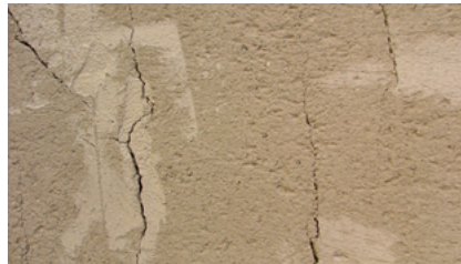
kleine Schwindrisse im frischen Zustand
