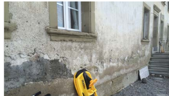
aufsteigende Feuchtigkeit
