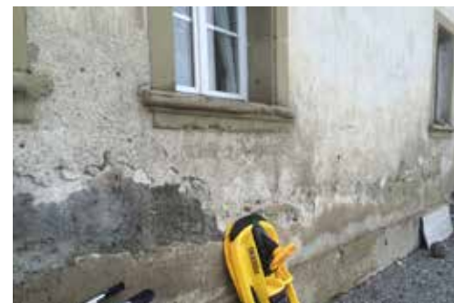
aufsteigende Feuchtigkeit
