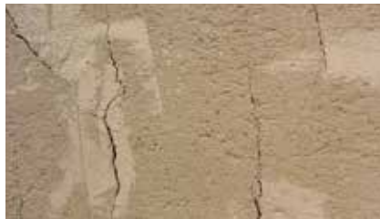
kleine Schwindrisse im frischen Zustand
