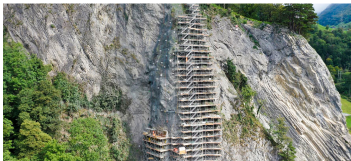
Stabilizarea stâncilor Axenstrasse, Sisikon UR
