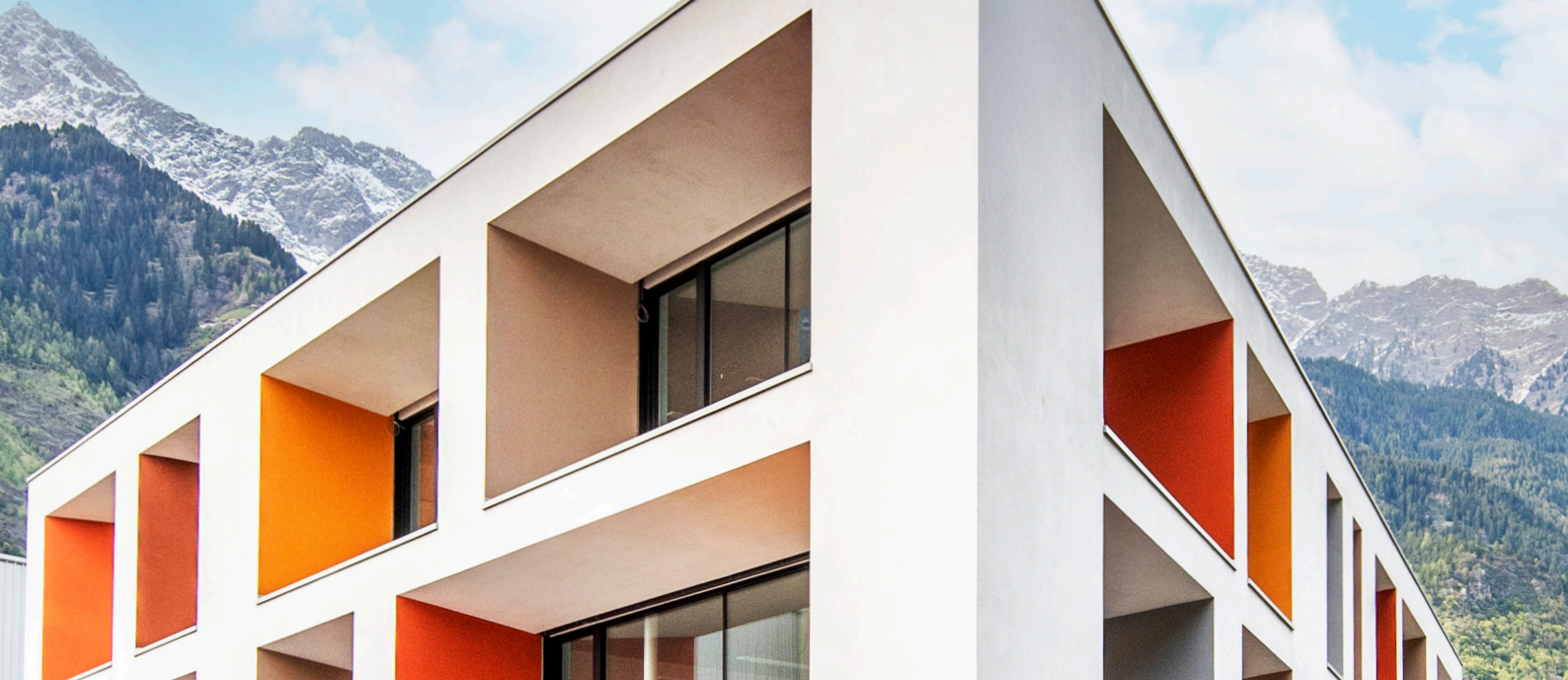
Fațada sediului RÖFIX Partschins. Italia
