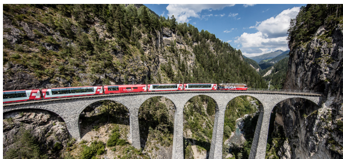
Viaductul Landwasser, Calea Ferată Retică, Elveția
