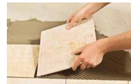
Lijepljenje keramičkih pločica
