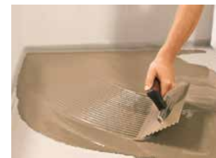
Nanošenje mase za niveliranje
