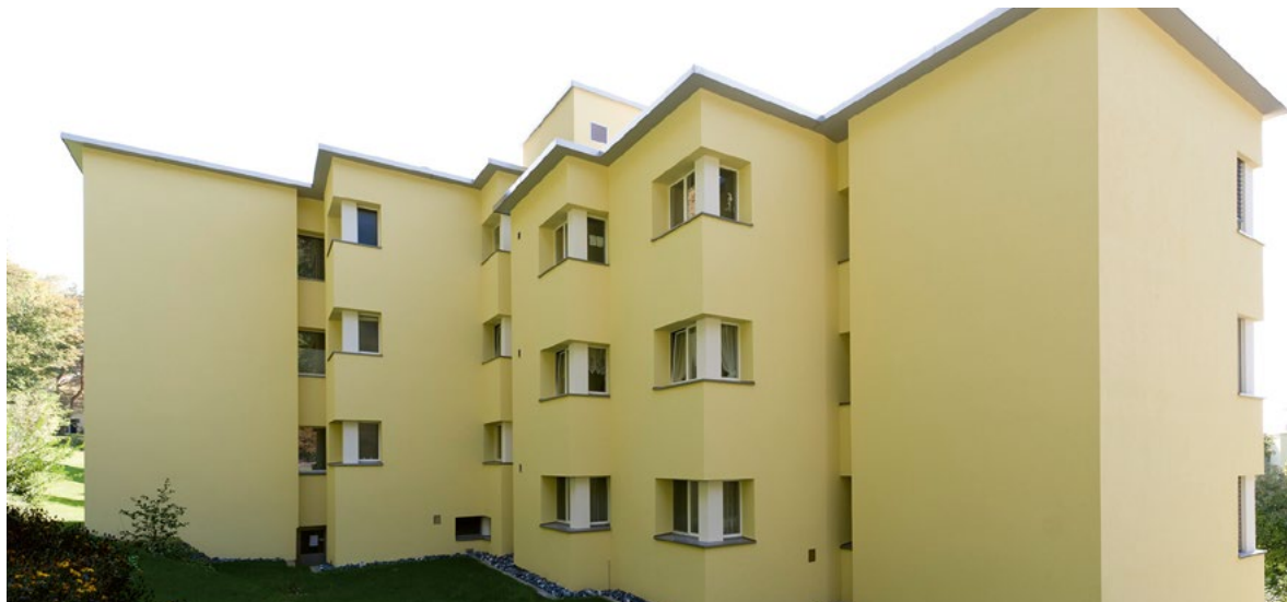
Sanierung Mehrfamiliengebäude in Uitikon Waldegg, Objektgrösse 2700 m 2 . Systemaufbau: Dämmung mit EPS Lambda light, 140 mm, Netzeinbettung Greutol Combi-Putz 488, Deckbeschichtung Greutol Silikon Deckputz 365 aussen Vollabrieb, 2.0 mm, Anstrich GreoColor OptiTop.
