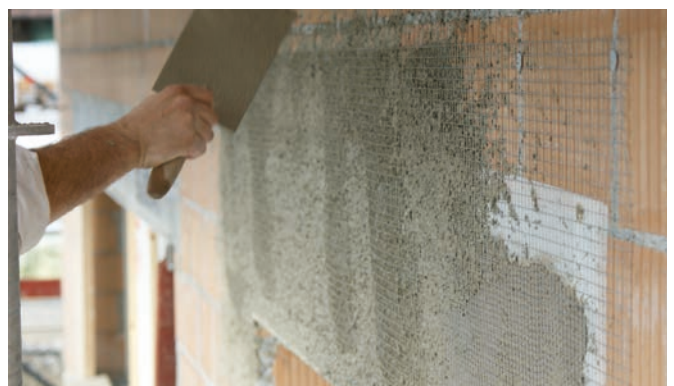
Zementmörtelanwurf Prégiclage au ciment
