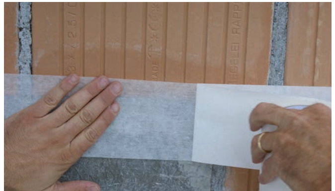
Trennvlies aufkleben Coller le non-tissé de séparation
