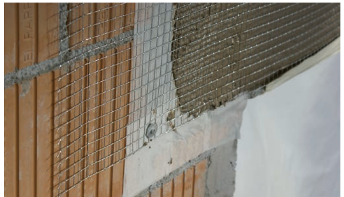
Armanet montieren Pose de l'Armanet
