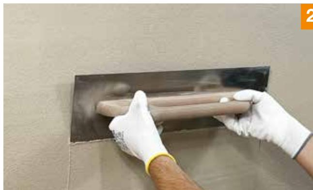
2. Nachdem die Grundbeschichtung getrocknet ist, werden die Traufelschläge gegebenenfalls geschliffen und im Anschluss wird der Fixit 745 Designputz als Deckputz mit einer Korn- und Schichtstärke von ca. 1,5 mm aufgezogen.
