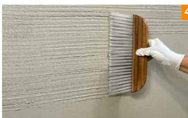
4. Den frischen Fixit 745 Designputz nass in nass mit der Aufräubürste horizontal und mit gleichmässigem Druck strukturieren.
