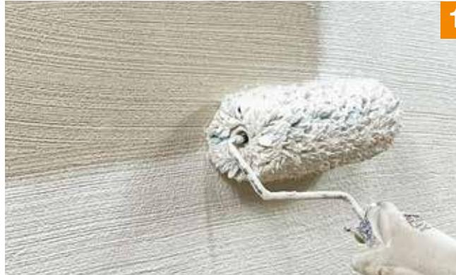
1. Wir empfehlen einen Voranstrich der aufgerauten Armierungsschicht mit der Fixit 475 Grundierung für mineralische Deckputze, um ein gleichmässiges Saugverhalten des Untergrundes zu gewährleisten.
