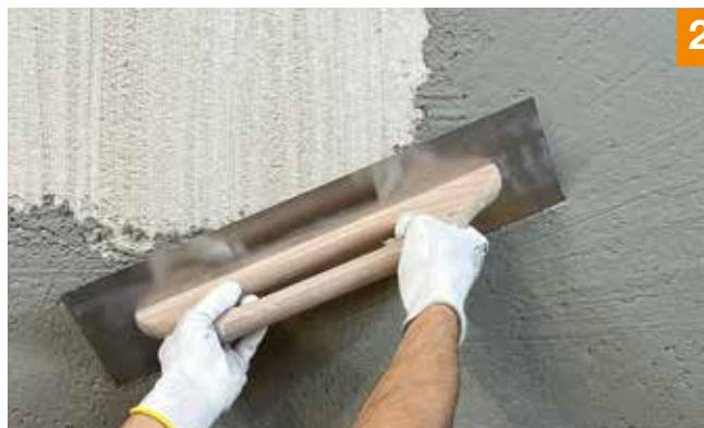
2. Durch das Vorlegen des Fixit 439 Klebemörtels wird der Materialverbrauch des Wormserputzes 490 stark verringert. Beim anschliessenden Anwerfen mit dem Wormser-Gerät wird dadurch die Anfangshaftung verbessert und es prallen weniger Körner ab.
