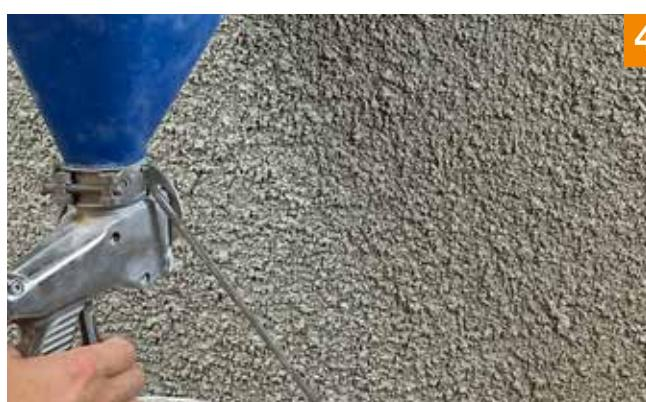
4. Alternativ kann der Wormserputz 490 auch mit der Trichterpistole oder einer anderen, geeigneten Putzmaschine aufgespritzt werden.
