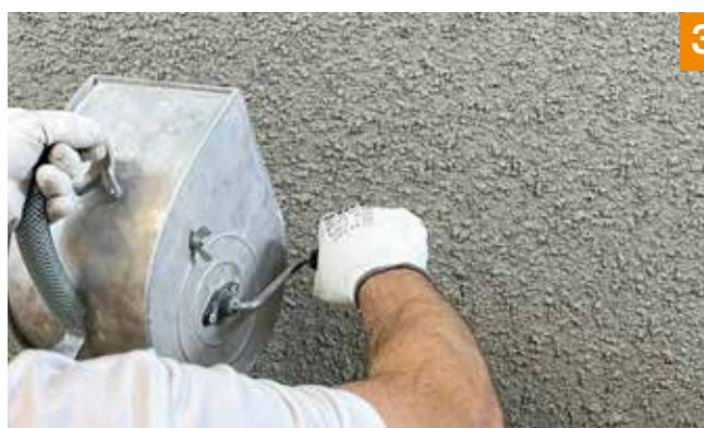
3. Der Wormserputz 490 wird mit dem Wormser-Gerät in schrägem Winkel angeworfen, um Gerüstabzeichnungen zu vermeiden.
