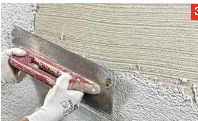
3. Auf die Armierungsschicht wird der Greutol Waschputz 794 im ersten Arbeitsgang knapp über Kornstärke aufgezogen.
