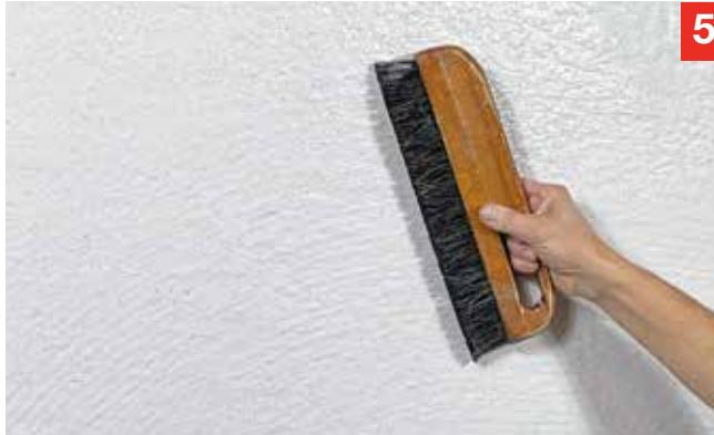
**5.** Der leicht angezogene Greutol Waschputz 794 wird mit einer feuchten Malerbürste mit wenig Druck mittels Kreuzschlag gewaschen.
