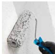
7 Auftragen des Farbanstrichs je nach Oberputz und Systemvorgabe
