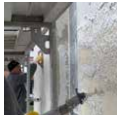
6 Auftragen des Oberputzes
