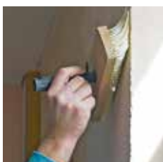
4 Auftragen des Verfestigers
