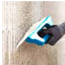
5 Einbetten des Armierungsgewebes mit Armierungsmörtel
