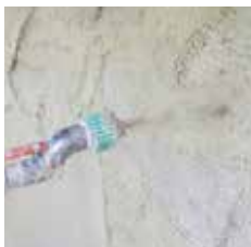
3 Aufbringen des Dämmputzes
