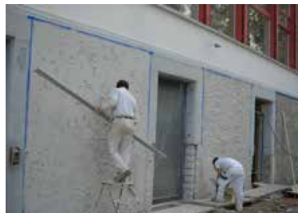
Sanierputz wird aufgetragen
