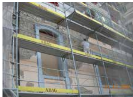
Verputz wird abgespitzt
