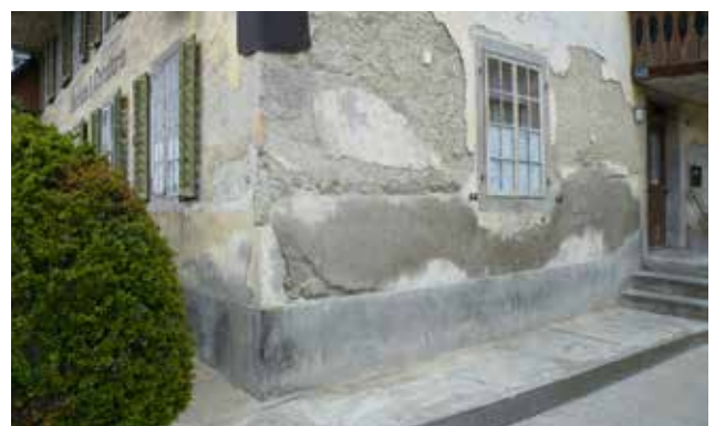
Efflorescences au-dessus de l'enduit ciment
