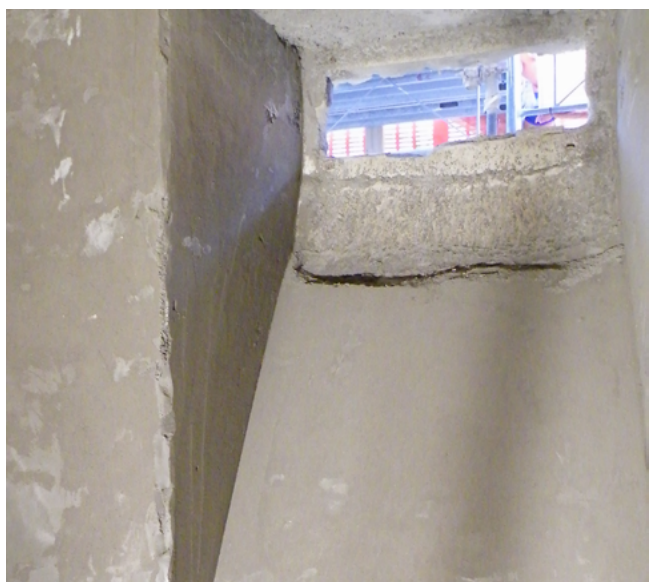
Etanchéité intérieure du mur extérieur avec enduit d'étanchéité
