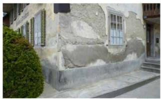
Efflorescences au-dessus de l'enduit ciment
