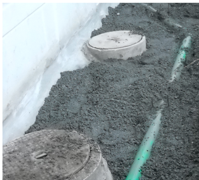
Etanchéité extérieure avec drainage
