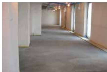
Sous-sol après l'application de l'enduit d'assainissement
