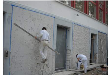
Sanierputz wird aufgetragen
