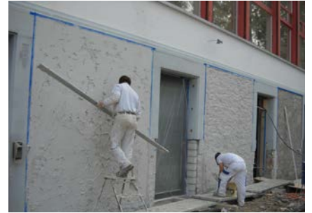
Application de l'enduit d'assainissement
