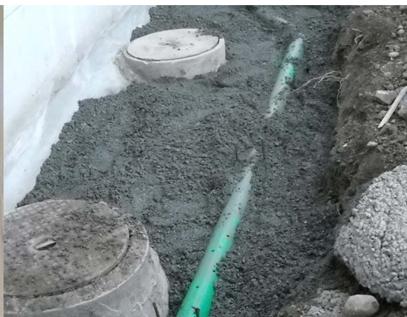
Etanchéité extérieure avec drainage
