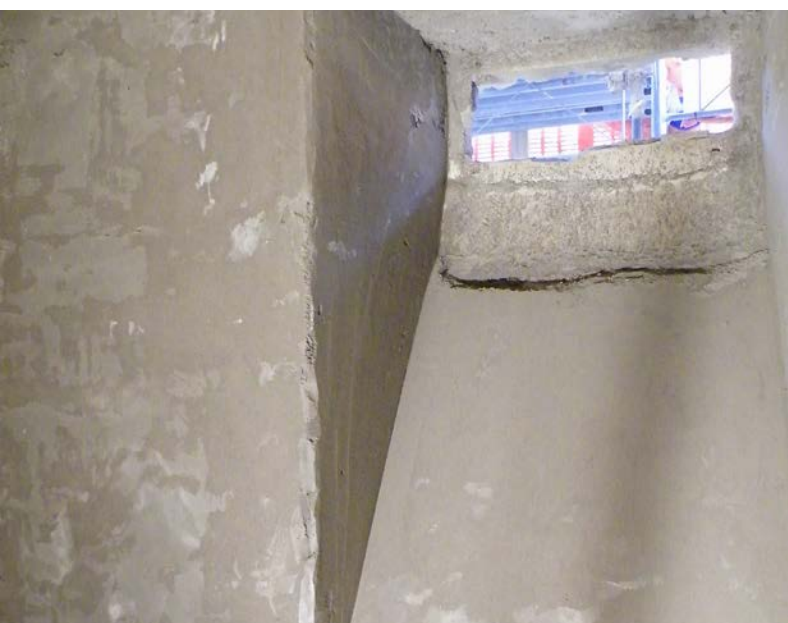
Etanchéité intérieure du mur extérieur avec enduit d'étanchéité
