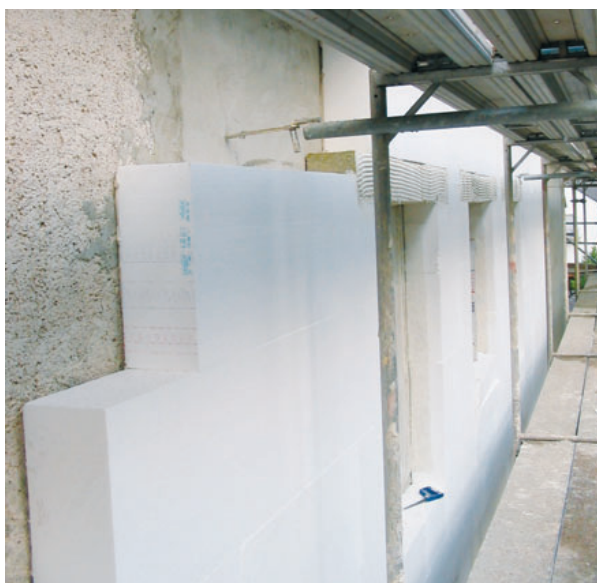
Bild 29: Wärmedämmverbundsystem mit Polystyrol
