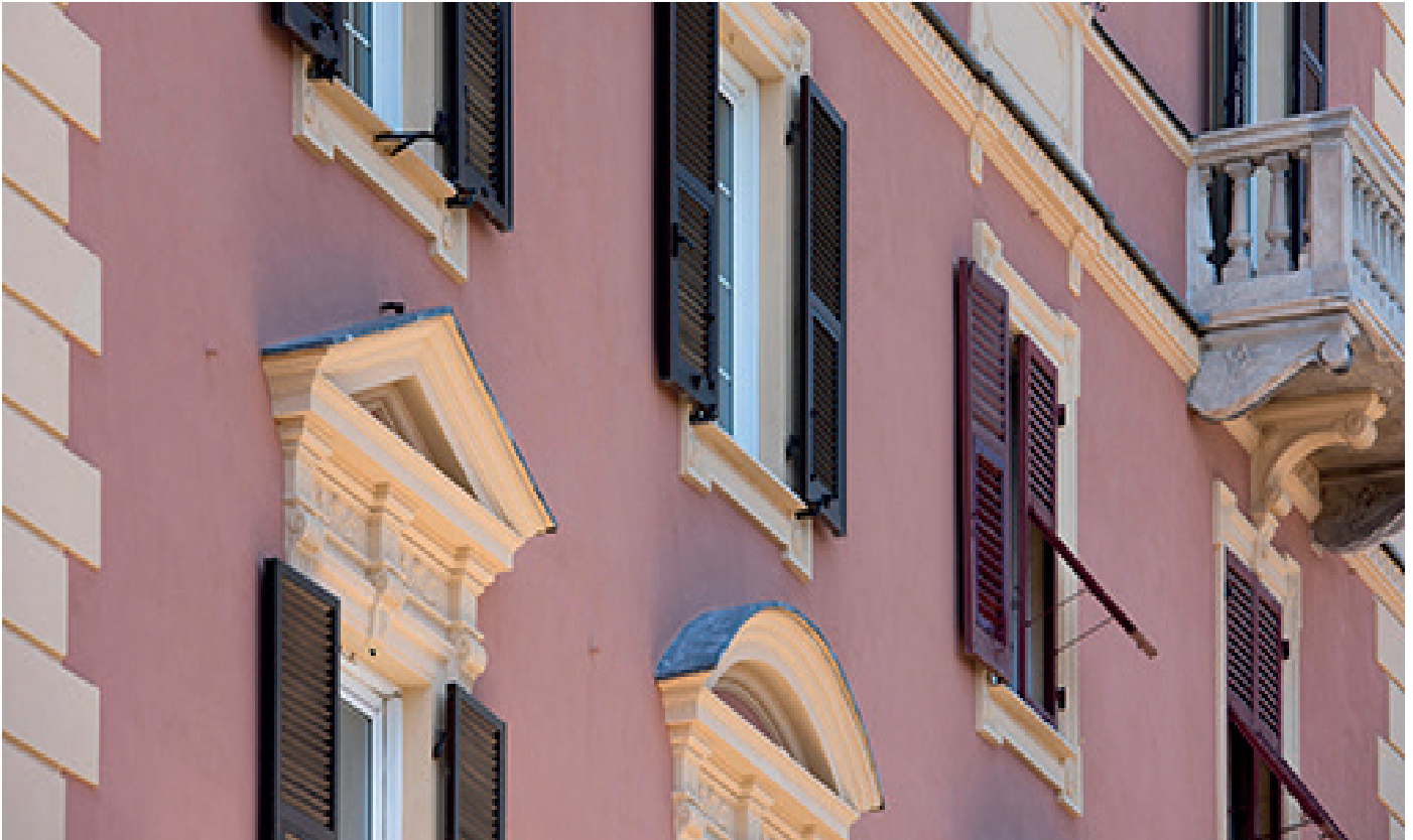
Sistemi di risanamento e restauro
