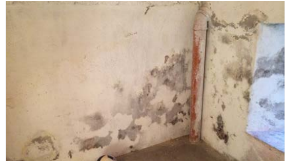
Pression de la pente de l'extérieur
