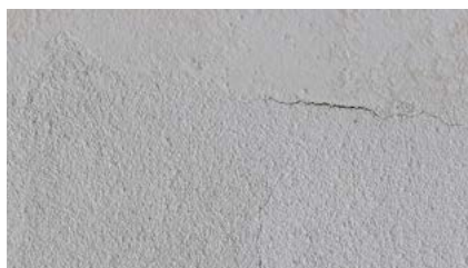
Fissures d'affaissement
