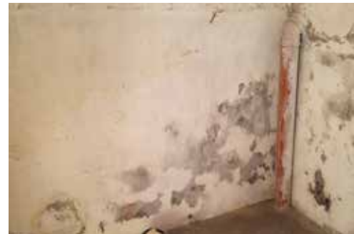
Pression de la pente de l'extérieur
