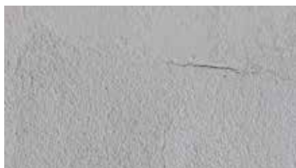
Fissures d'affaissement
