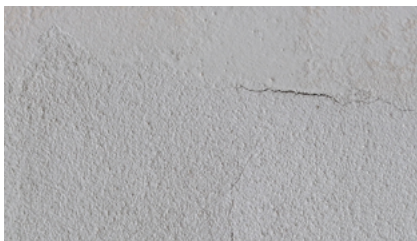
Fissures d'affaissement
