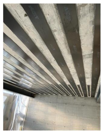
En fonction des nombreuses armatures collées, l'entrepreneur doit lui-même déterminer la variante qui lui convient le mieux. La variante Stucanet® est plus sûre que le pont d'adhérence spécial (formation de fissures à la jonction des matériaux). Une garantie quant aux fissure suite à des mouvements ne peut pas être assumée.
