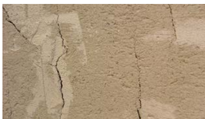
Fissures de retrait sur la couche fraîche
