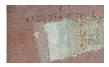
En règle générale, les couches d'enduit deviennent de plus en plus souples, de la maçonnerie à la couche supérieure!
