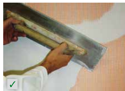
Armirni sloj kod problematičnih podloga RÖFIX Renostar®, RÖFIX Renoplus®
