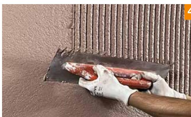
4. Der noch frische Fixit 793 Steinputz wird in Richtung der Zahnung ausgeglättet, dabei darf kein Material abgetragen werden.
