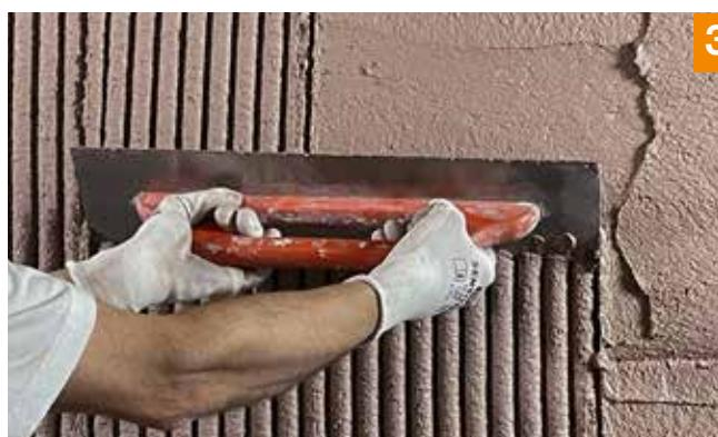
3. Am Folgetag wird der Fixit 793 Steinputz (Körnung: 2 mm) manuell oder maschinell aufgebracht. Mit der Zahntraufel R16 wird der Putz gleichmässig in eine Richtung im 45°-Winkel durchgekämmt.
