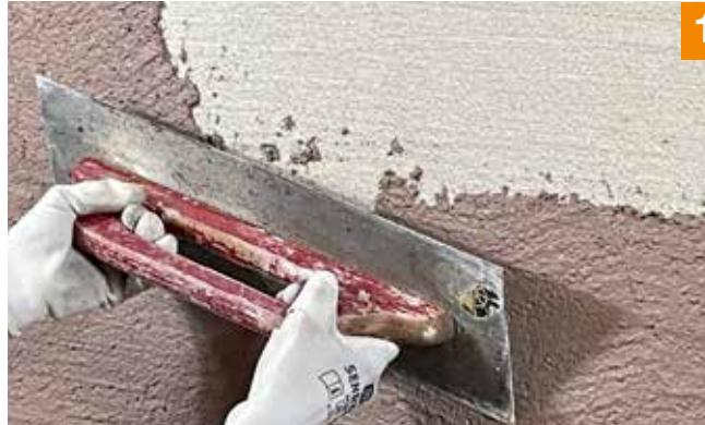
1. Auf die horizontal aufgerautete Armierungsschicht wird der Fixit 793 Steinputz (Körnung: 2 mm) im ersten Arbeitsgang auf Kornstärke aufgezogen.
