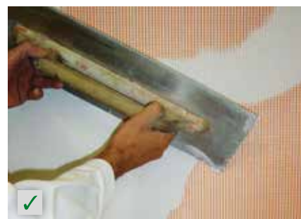
Armaturni sloj kod problematičnih podloga RÖFIX Renostar®, RÖFIX Renoplus®
