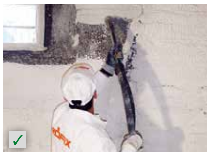
Izravnavanje podloge prije nanošenja završnih premaza (nove boje, završne žbuke) RÖFIX Renoplus®
