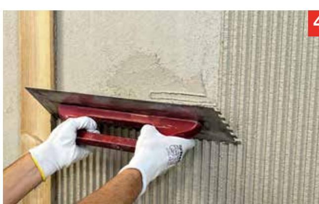
4. Égaliser le crépi décoratif Fixit 745 sur l'épaisseur grain et passer au peigne avec la truelle dentée 10x10 mm avec un angle de 45°.
