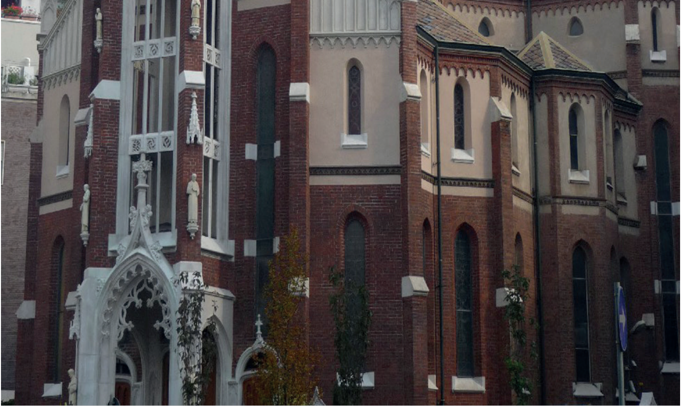
Sistemi di risanamento e restauro
