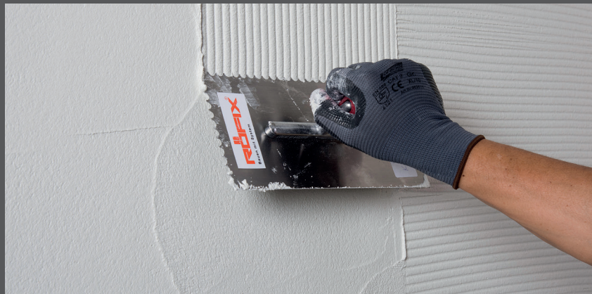
Aerisiți suprafața cu mistria dințată ascuțită RÖFIX S6
