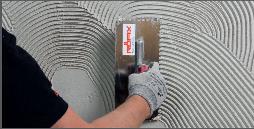
Realizați striații cu sistemul de lipire și armare RÖFIX
