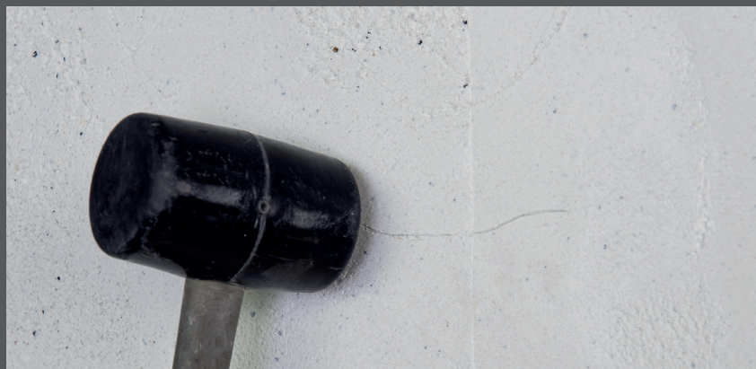
Folosiți ciocanul de cauciuc pentru compactarea tencuielii drișcuite RÖFIX 772
