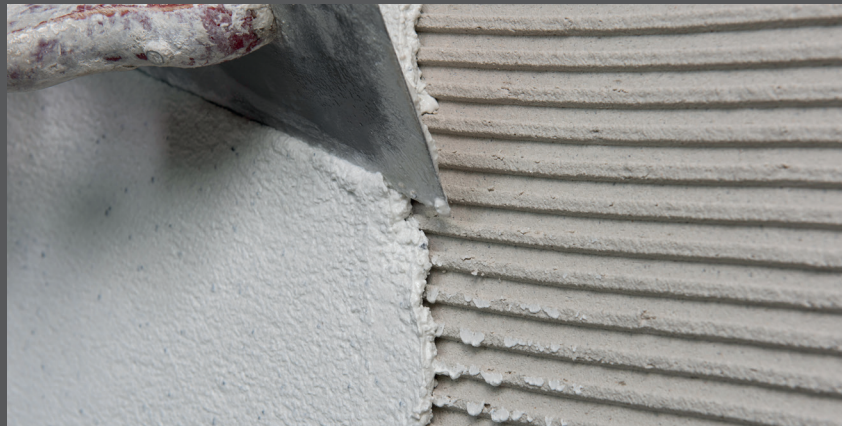
Aplicați tencuiala drișcuită RÖFIX 772 cu mistria dințată peste sistemul de lipire și armare pregătit
