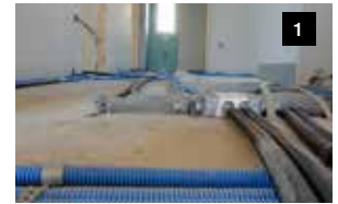
1 Boden vorbereiten und Leitungen fixieren
