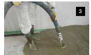
3 HASIT POR® aus dem Schlauch einfließen lassen
