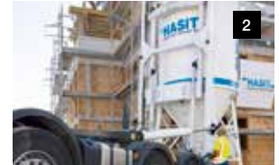
2 Nach der Silo-Anlieferung wird die Konsistenz eingestellt
