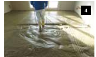
4 Nachträglich eibebnen und abziehen mittels Schwabbelstange
