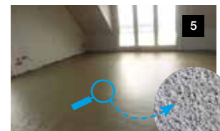
5 Fertig! Begehbar nach 24 - 72 Stunden
