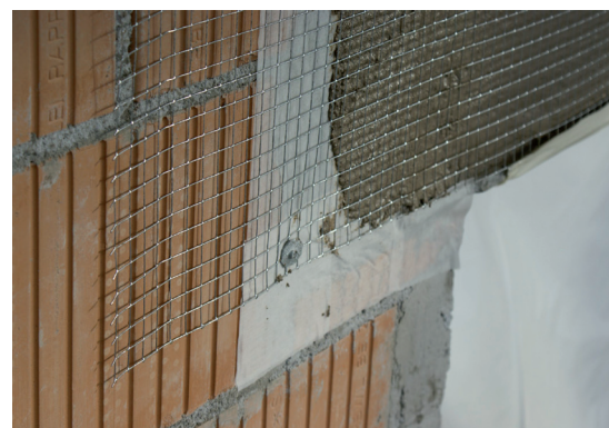
Posa di rete metallica tipo Armanet fissata meccanicamente
