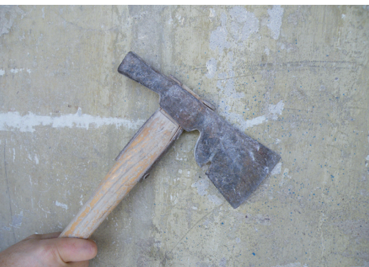
Controllo dell'adesione dell'intonaco
