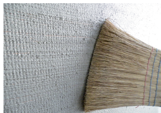
Strato intermedio irruvidito orizzontalmente con scopa
