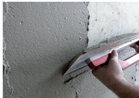
Applicare una rasatura di risanamento
