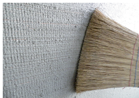
Strato intermedio irruvidito orizzontalmente con scopa
