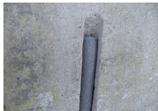
Posa di un profilo spugnoso
