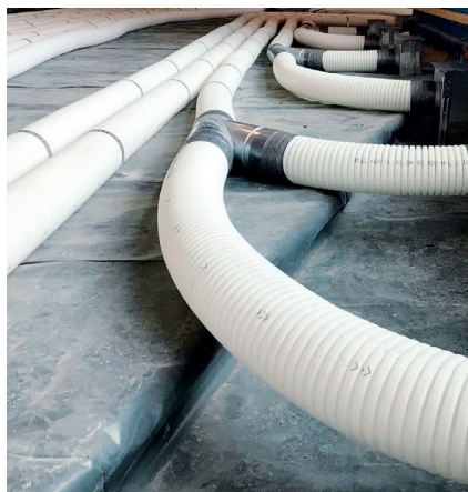
Flächen vorgängig mit PE-Folie abkleben
