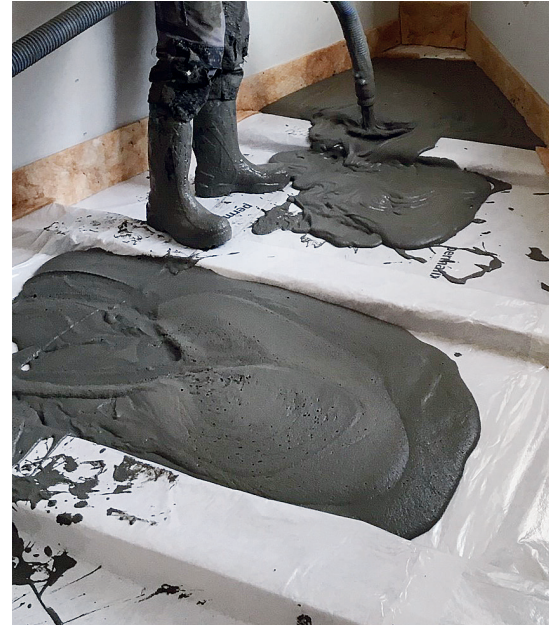
RÖFIX POR® Einbau auf Holzbalkendecke
