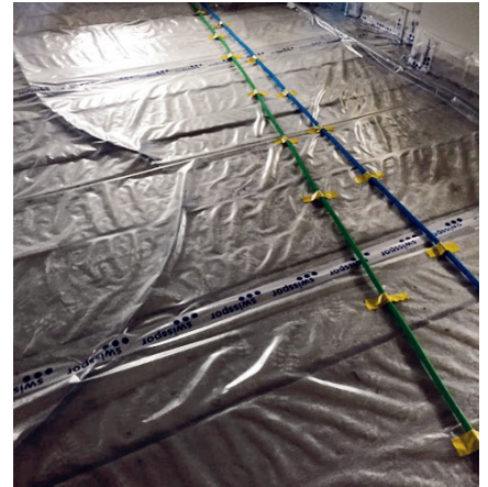
Abdecken mit PE-Folie (doppelt) bei bewohnten Objekten
