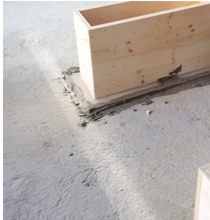
Abdichtung der Schalungen mit Schnellmörtel oder Bauschaum
