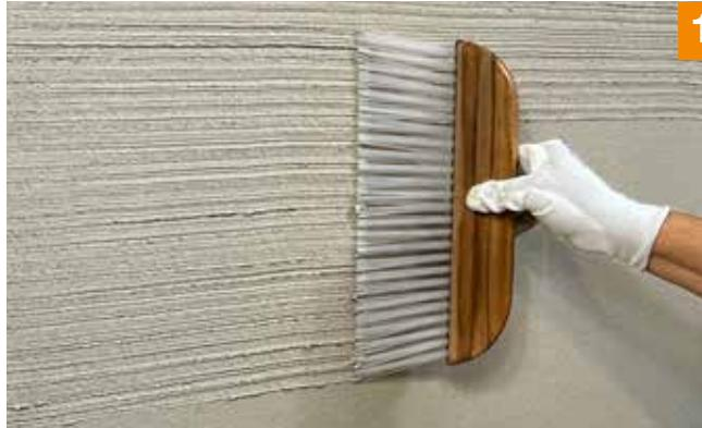
1. Die Armierungsschicht wird für den nachfolgenden Putzauftrag horizontal mit einem Besen aufgeraut.
