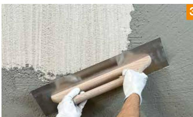
3. Durch das Vorlegen des Fixit 439 Klebemörtels wird der Materialverbrauch des Fixit 764 Kellenwurf stark verringert. Beim anschliessenden Anwerfen mit dem Putzspritzgerät wird dadurch die Anfangshaf-
