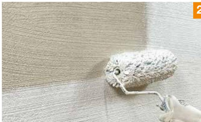
2. Wir empfehlen einen Voranstrich der aufgerauten Armierungsschicht mit der Fixit 475 Grundierung für mineralische Deckputze, um ein gleichmässiges Saugverhalten des Untergrundes zu gewährleisten.
