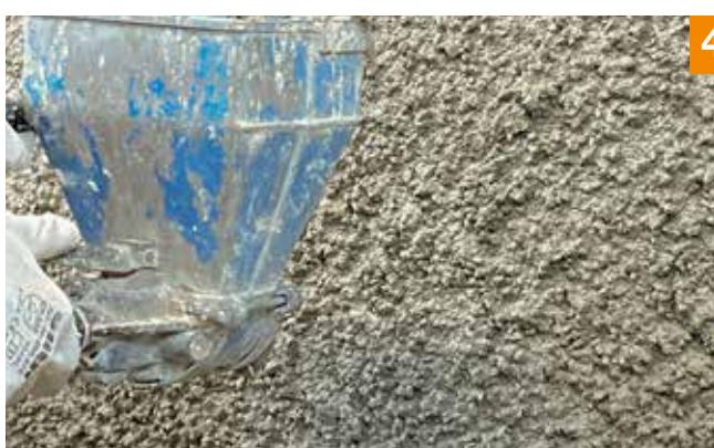
4. Der Fixit 764 Kellenwurf (Körnung: 6–8 mm) wird mit dem Enduivit 3 Putzspritzgerät in schrägem Winkel stossweise eingeblasen, um Gerüstabzeichnungen zu vermeiden.
