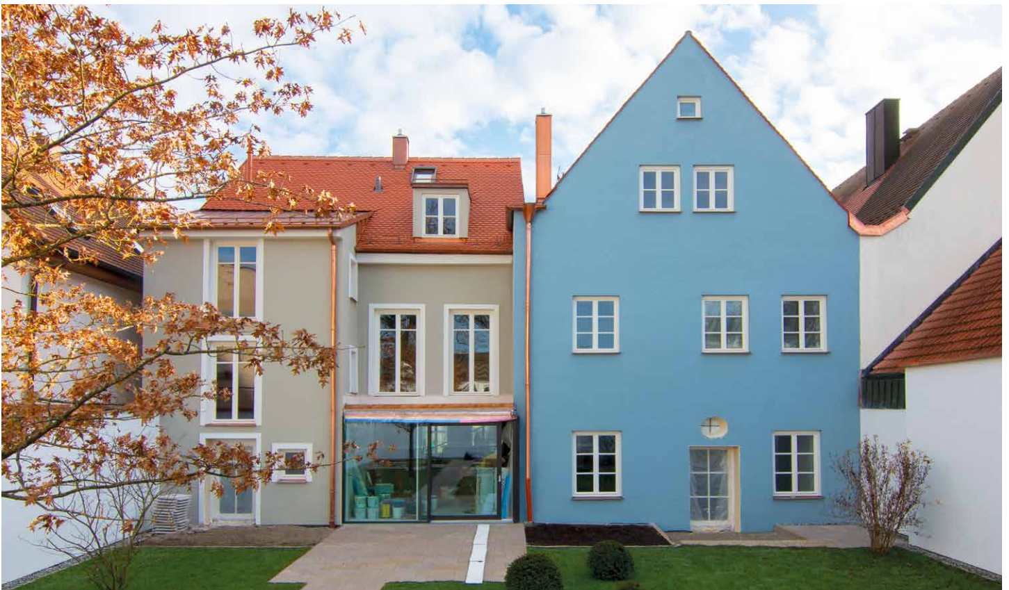
Das fertig renovierte Domherrenhaus in Freising.
