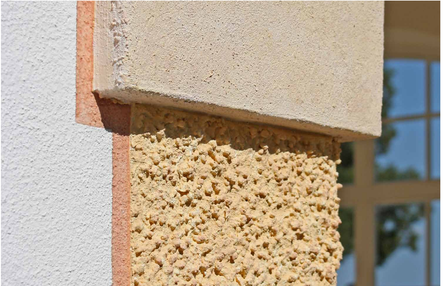
Außenfassade mit Fensterumrahmungen aus 8 mm Kellenwurf und aufgeputzten Faschen, Stuck und Vorsprüngen.
