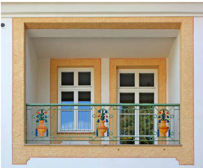
Außenfassade mit Fensterumrahmungen aus 8 mm Kellenwurf und aufgeputzten Faschen, Stuck und Vorsprüngen.
