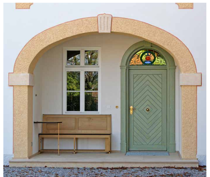
Außenfassade mit Fensterumrahmungen aus 8 mm Kellenwurf und aufgeputzten Faschen, Stuck und Vorsprüngen.
